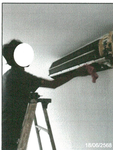
รูปภาพที่ 2.42 การล้างทำความสะอาดเครื่องปรับอากาศ
